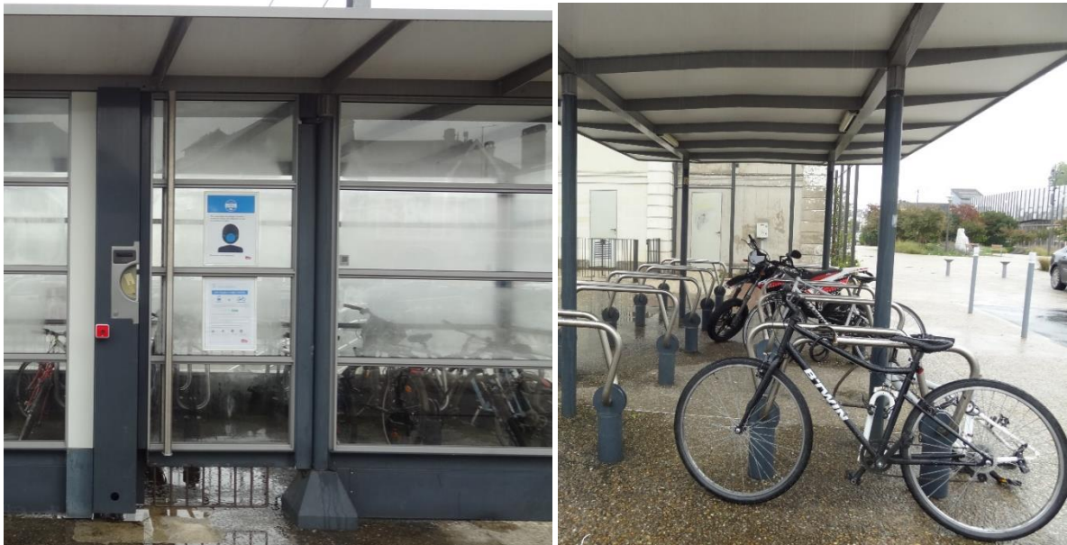
Exemple de la gare d'Ancenis qui dispose de plusieurs stationnements avec des degrés de sécurisation différents.
